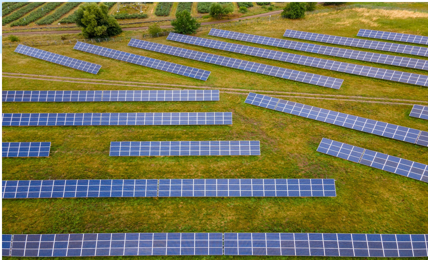
Instalacja fotowoltaiczna w ZPW Pilchowo
